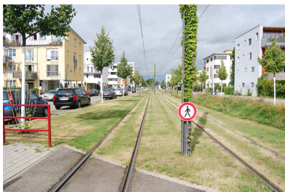
Fig. 2-3 - Quartiere Vauban - Friburgo, Germania
